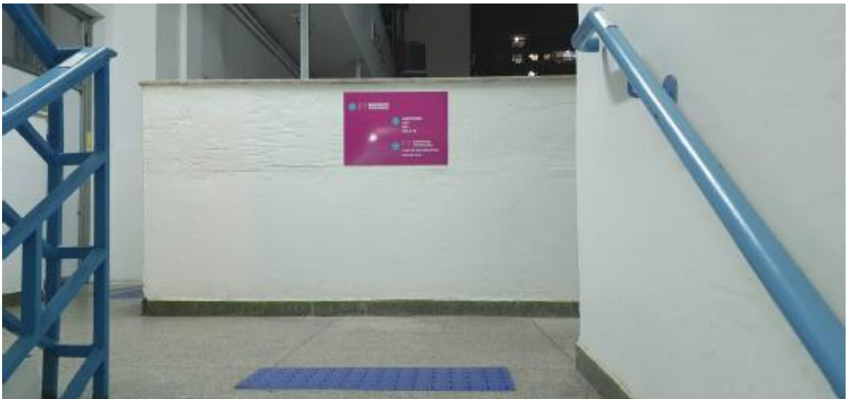
Figura 50: Escadas com corrimão com sinalização em braille e piso tátil
