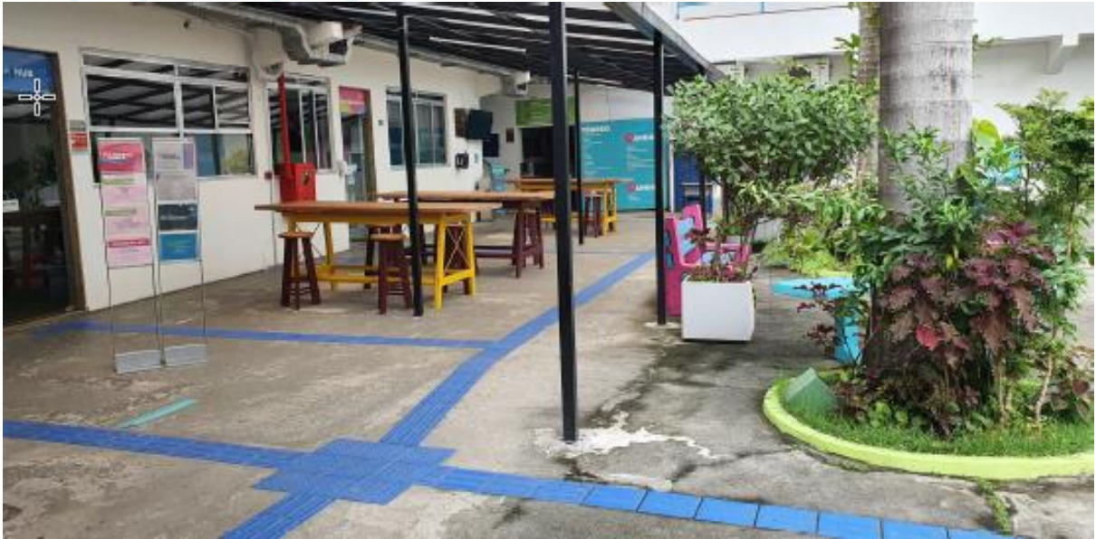
Figura 49: Pátio com rota acessível
