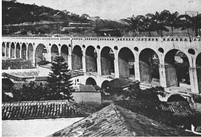
Aqueduto da Carioca
